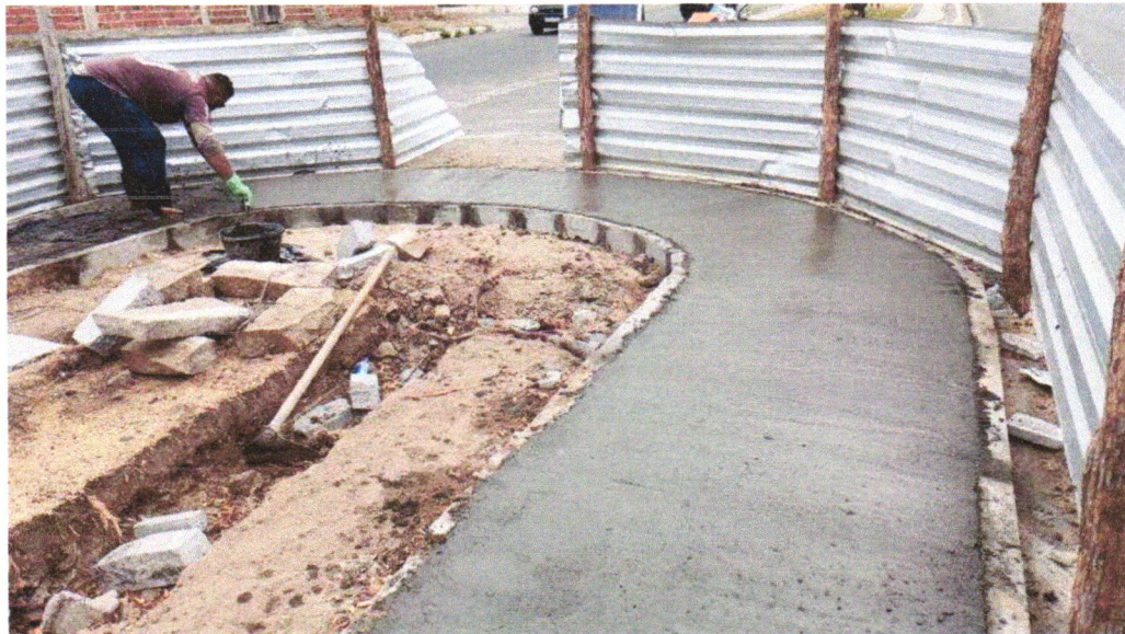
Foto 07 - PAVIMENTAÇÃO EM CONCRETO, COM ESPESSURA DE 7 CM, COM ACABAMENTO FEITO UTILIZANDO ALISADORA DE CONCRETO (HELICOPTERO), INCLUIDO TELA DE AÇO SOLDADA NERVURADA CA60, Q196 (3,11 KG/M 2 ), DIÂMETRO DO FIO 5.0 MM, LARGURA = 2,45 M, ESPAÇAMENTO DA MALHA = 10 X 10 CM, JUNTA DE DILATAÇÃO EM PVC A CADA 2,00 M, CONCRETO FCK = 20 MPA
