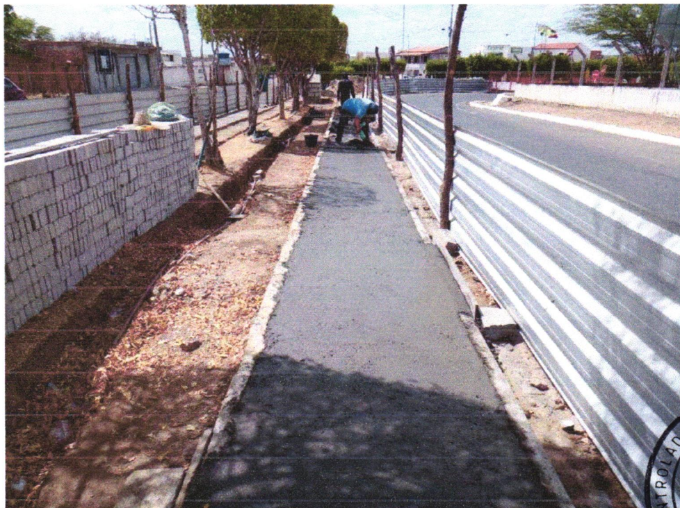
Foto 08 - PAVIMENTAÇÃO EM CONCRETO, COM ESPESSURA DE 7 CM, COM ACABAMENTO FEITO UTILIZANDO ALISADORA DE CONCRETO (HELICOPTERO), INCLUIDO TELA DE AÇO SOLDADA NERVURADA CA60, Q196 (3,11 KG/M 2 ), DIÂMETRO DO FIO 5.0 MM, LARGURA = 2,45 M, ESPAÇAMENTO DA MALHA = 10 X 10 CM, JUNTA DE DILATAÇÃO EM PVC A CADA 2,00 M, CONCRETO FCK = 20 MPA
