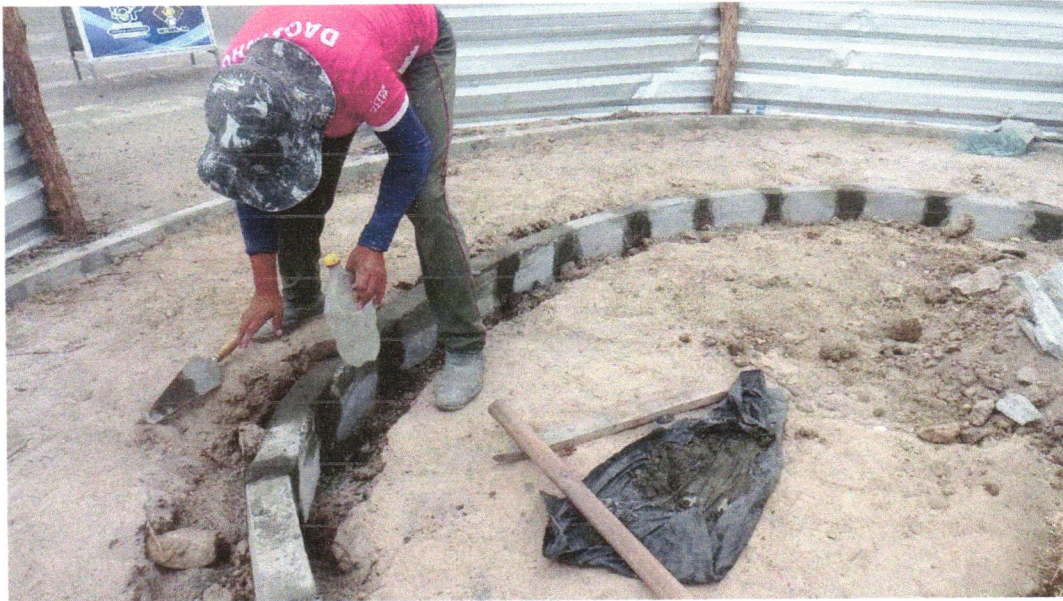
Foto 05 - ASSENTAMENTO DE GUIA (MEIO-FIO) EM TRECHO CURVO, CONFECCIONADA EM CONCRETO PRÉ-FABRICADO, DIMENSÕES 100X15X13X20 CM (COMPRIMENTO X BASE INFERIOR X BASE SUPERIOR X ALTURA), PARA URBANIZAÇÃO INTERNA DE EMPREENDIMENTOS. AF_06/2016_P
