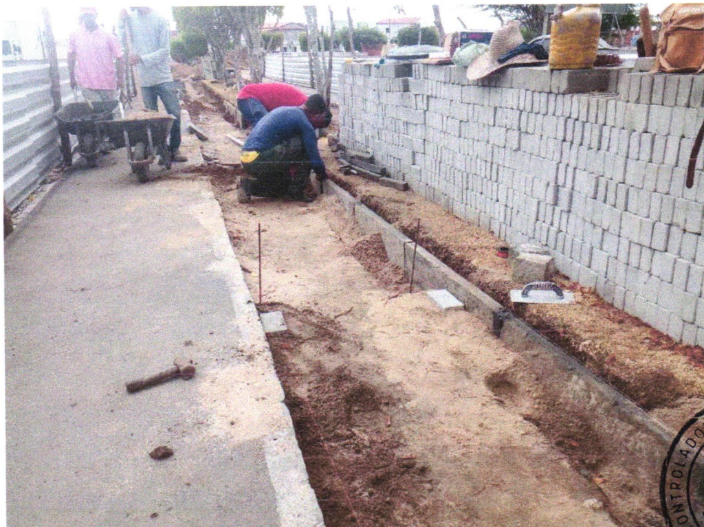
Foto 06 - ASSENTAMENTO DE GUIA (MEIO-FIO) EM TRECHO RETO, CONFECCIONADA EM CONCRETO PRÉ-FABRICADO, DIMENSÕES 80X08X08X25 CM (COMPRIMENTO X BASE INFERIOR X BASE SUPERIOR X ALTURA), PARA URBANIZAÇÃO INTERNA DE EMPREENDIMENTOS. AF_06/2016
