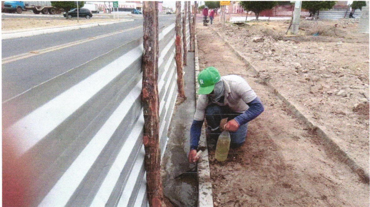
Foto 03- ASSENTAMENTO DE GUIA (MEIO-FIO) EM TRECHO RETO, CONFECCIONADA EM CONCRETO PRÉ-FABRICADO, DIMENSÕES 100X15X13X20 CM (COMPRIMENTO X BASE INFERIOR X BASE SUPERIOR X ALTURA), PARA URBANIZAÇÃO INTERNA DE EMPREENDIMENTOS. AF_06/2016_P
